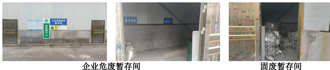
图 10-3 固废暂存情况
