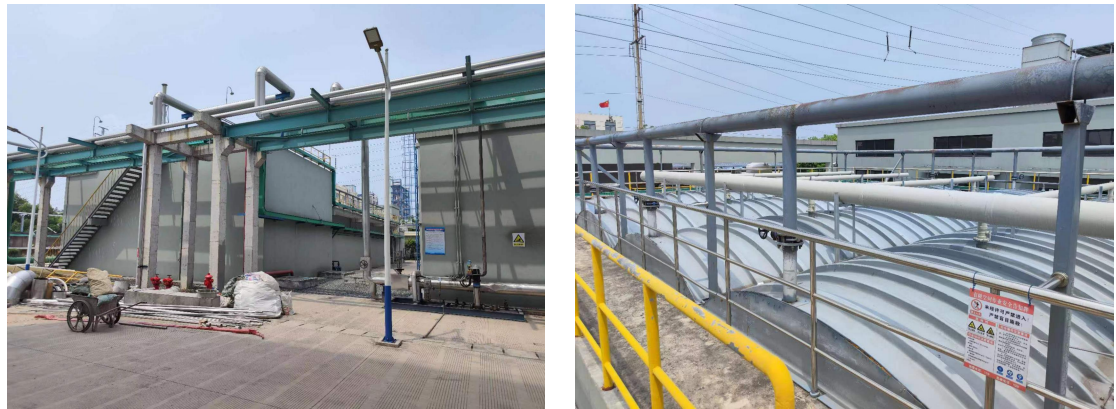
图 4-2 项目污水处理站
