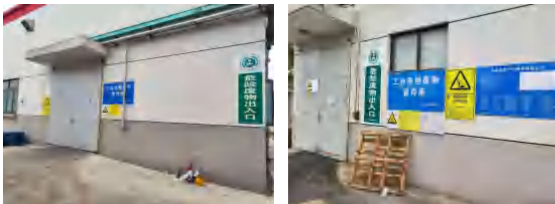
图 10-3 企业危废暂存间
