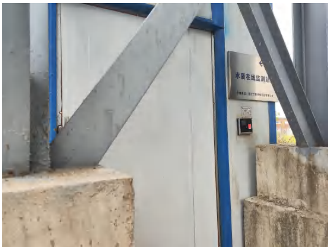
废水在线监控 图 10-4 在线监控
