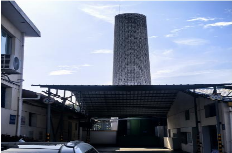
图3-2 项目废气处理设施
